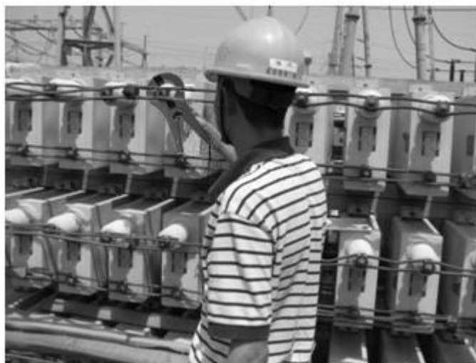
图 4 仪器现场测量实例
